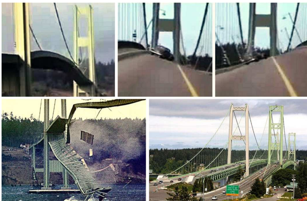
Obr. 7: Most v Tacomě (USA, stát Washington) o délce 1810 m se rozkmital divergentním samobuzeným ohybovým a torzním kmitáním, které způsobilo jeho zřícení dne 7. 11. 1940. Poté byly postaveny dva nové mosty: r. 1952 (vpravo) a r. 2007 (vlevo). Sestaveno z internetových zdrojů [5]
